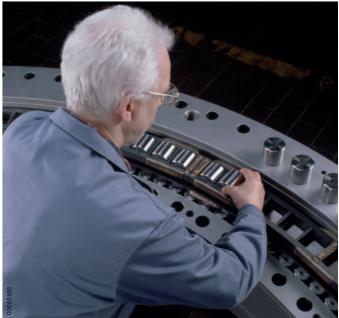
Kuva 1 Tunnelinporauskoneen vierintälaakereiden kunnostus, vierintäelinten asennus
